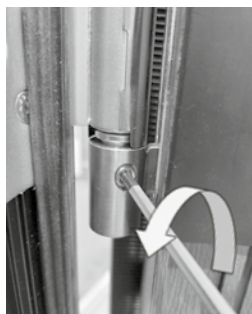
Odkręcić śrubę ustalającą.
