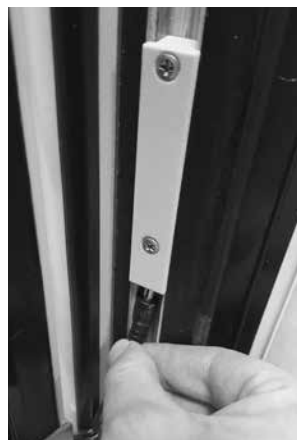
4. Podłączyć wtyczkę do gniazda do ładowania, zamknąć okno i podłączyć ładowarkę do gniazodka
